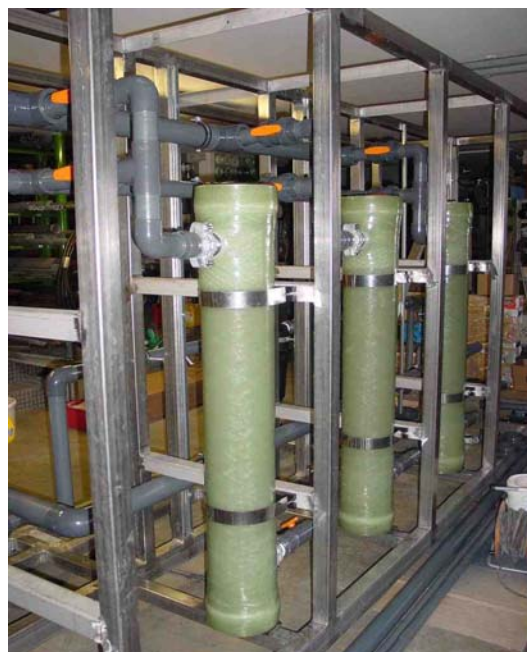
Vedere laterală în interiorul containerului
