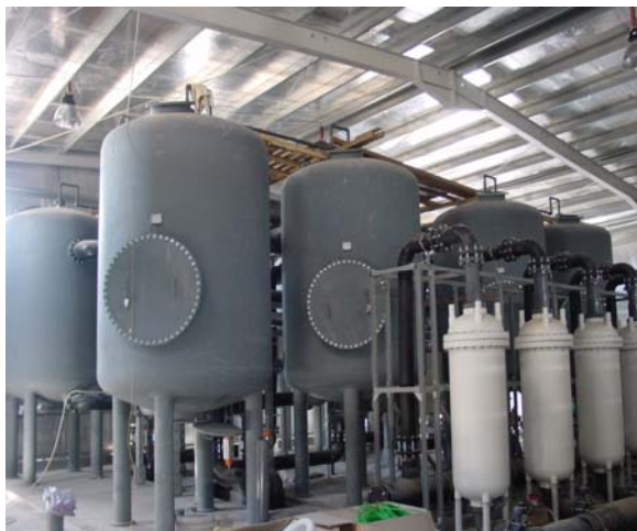
Prefiltrare (filtrele stratificate și filtrele cartuș)
