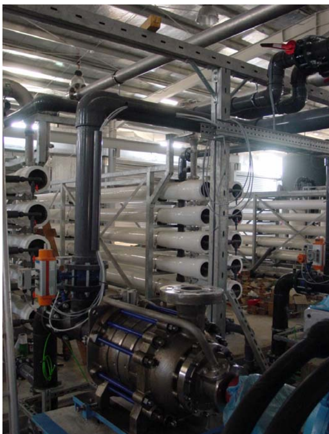
Pompa de înaltă presiune și modulele de osmoză
